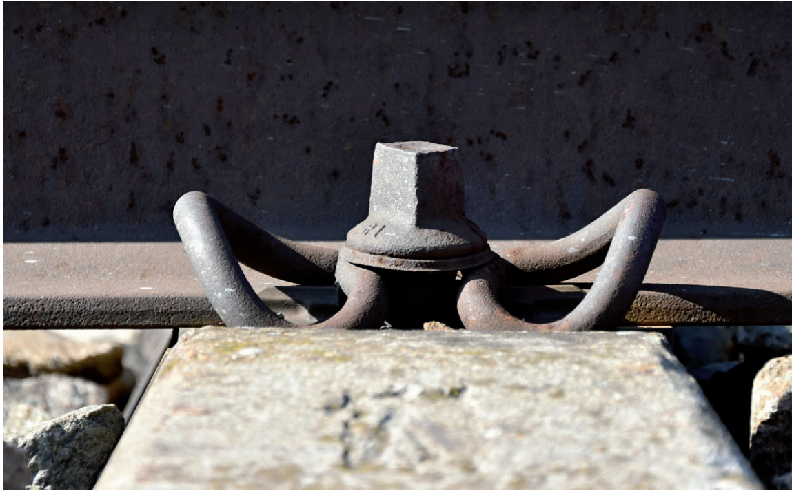
在轨道上部结构区域使用的轨夹须能够承受高动态力、各种气候影响、高温差和化学冲击。
